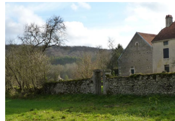
Mur de pierre à Essarois (21), avec porte piétonne ouvrant sur une prairie attenante © Parc national de forêts
