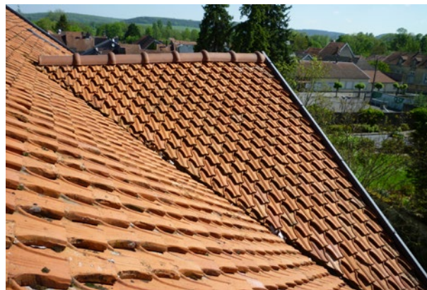
Un toit restauré en tuiles violon à Montigny-sur-Aube (21) © Bernard BONNEVIE
