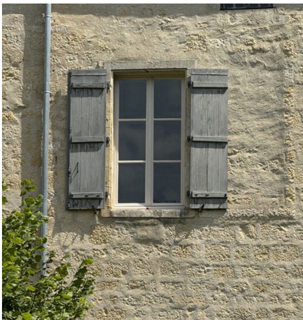
Une fenêtre traditionnelle à six carreaux, petits bois, jet-d'eau en doucine et appui en quart-de-rond à Rouelles (52) © Parc national de forêts
