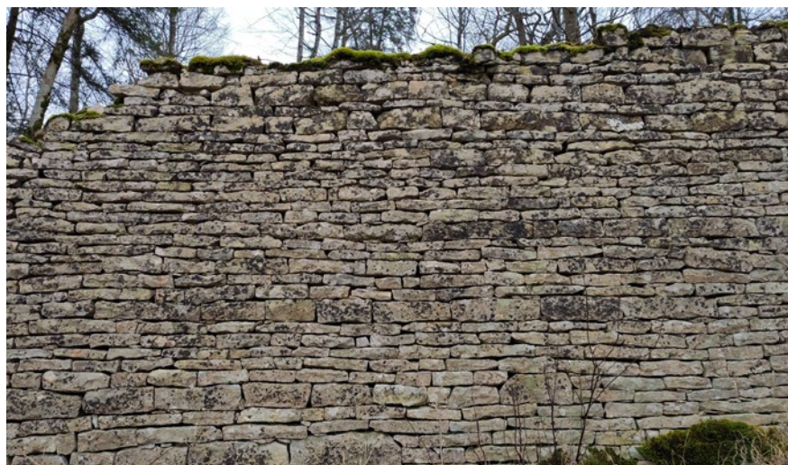
Un mur de clôture en pierre sèche. © Parc national de forêts
