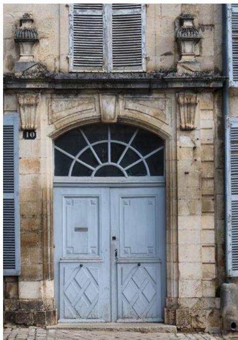
Détail d'un portail d'une demeure de Châtillon-sur-Seine (21) © Parc national de forêts
