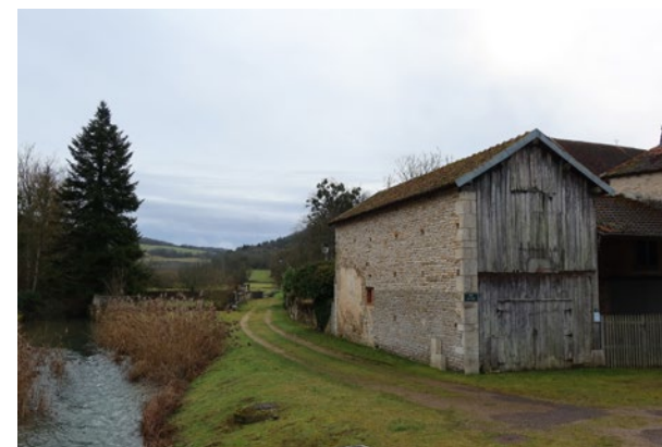
Un bardage en bois sur un hangar à Montmoyen (21) © Parc national de forêts
