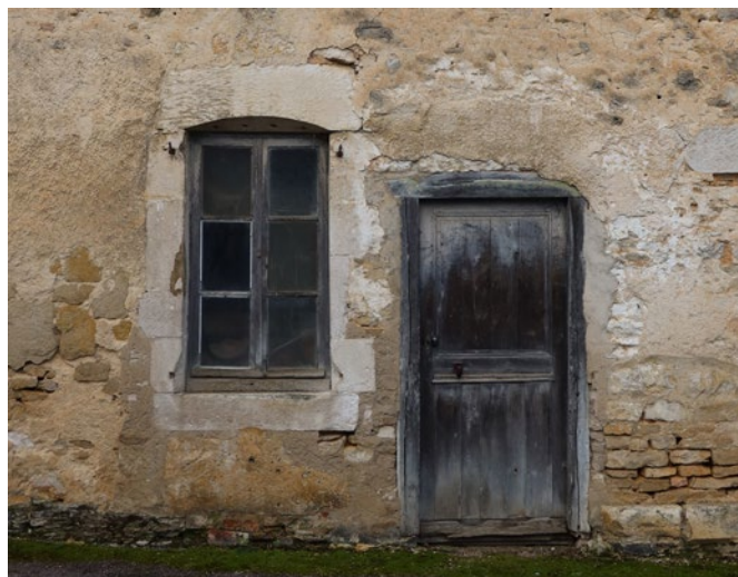
Un encadrement couvert d'un arc segmentaire (ou surbaissé) dans une demeure de Châteauvillain (52) © Parc national de forêts
