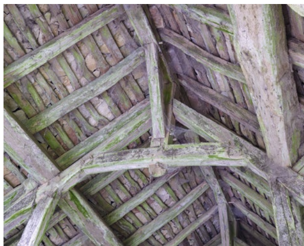
La charpente du lavoir de Châtillonot (Le Val-d'Esnois, 52) © SRI-GE
