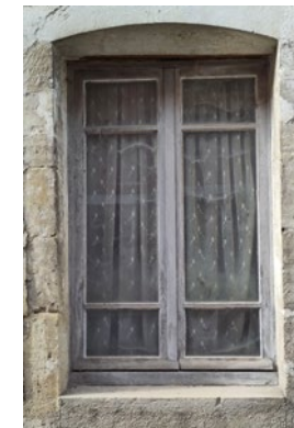
Des fenêtres dont le profil général est traditionnel mais dont les petits bois sont excentrés, à Châteauvillain (52) et Montigny-sur-Aube (21) © Parc national de forêts
