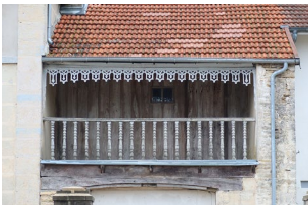
Le lambrequin d'une galerie extérieure à Montigny-sur-Aube (21) © Parc national de forêts
