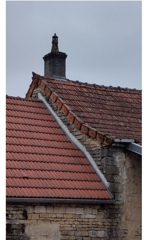
Une rive revêtue de tuiles à motifs © Parc national de forêts
