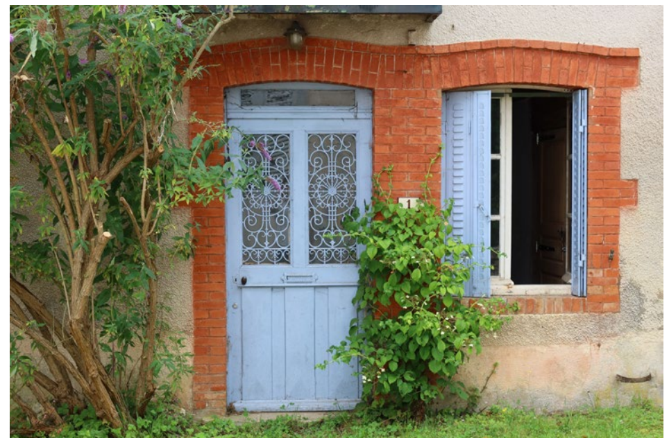
Encadrements en brique d'une maison de village à Rochefort-sur-Brévon (21) © Parc national de forêts
