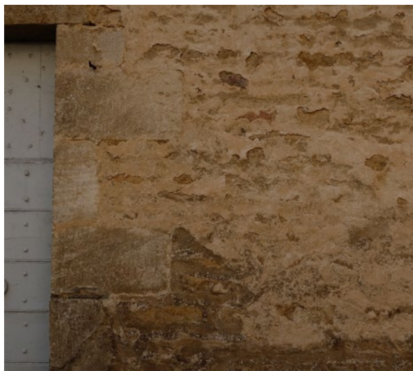
Une maçonnerie de moellons enduite à « pierres-vues » © Parc national de forêts
