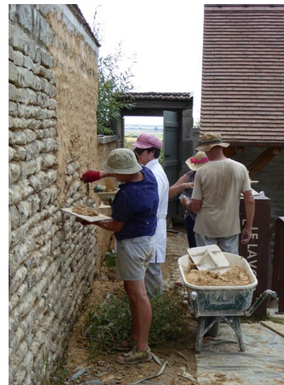
Un stage de jointoiement à « pierres vues » © Villages anciens, Villages d'avenir
