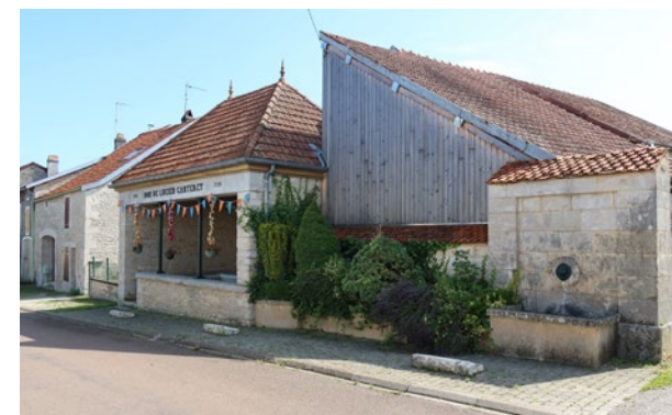
La « lavoir Carteret » à Saint-Loup-sur-Aujon (52) © Parc national de forêts
