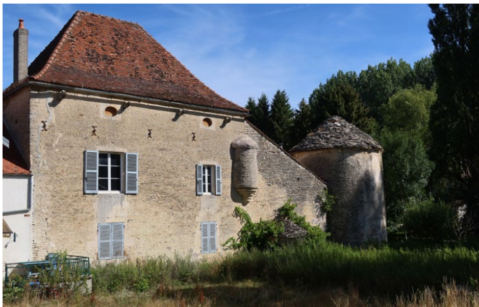
Une demeure, ancienne maison forte, à Vauxhautes-sur-Aube (21) © Parc national de forêts
