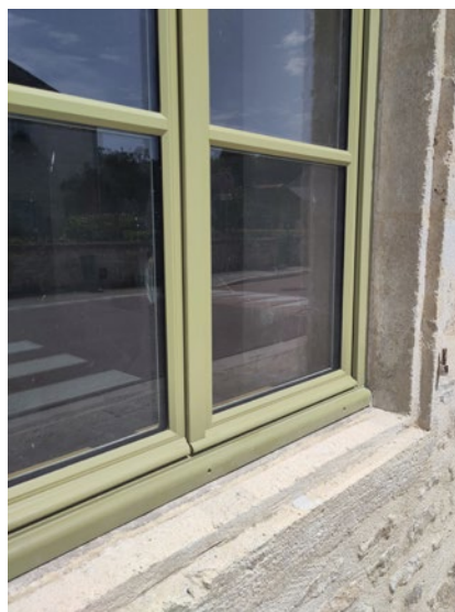
Détails de fenêtres restituées d'après des profils traditionnels, avec pièce d'appui en quart-de-rond et jet d'eau en doucine © Parc national de forêts
