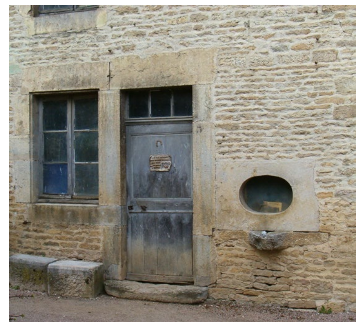
Des portes et fenêtres à encadrement droit, complétées d'un oculus éclairant la niche d'évier, à Montigny-sur-Aube (21) © Parc national de forêts
