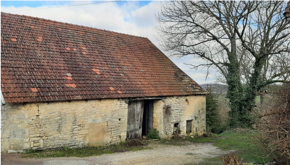
Le toit en tuiles mécaniques losangées d'une grange à Aulnoy-sur-Aube (52) © Parc national de forêts
