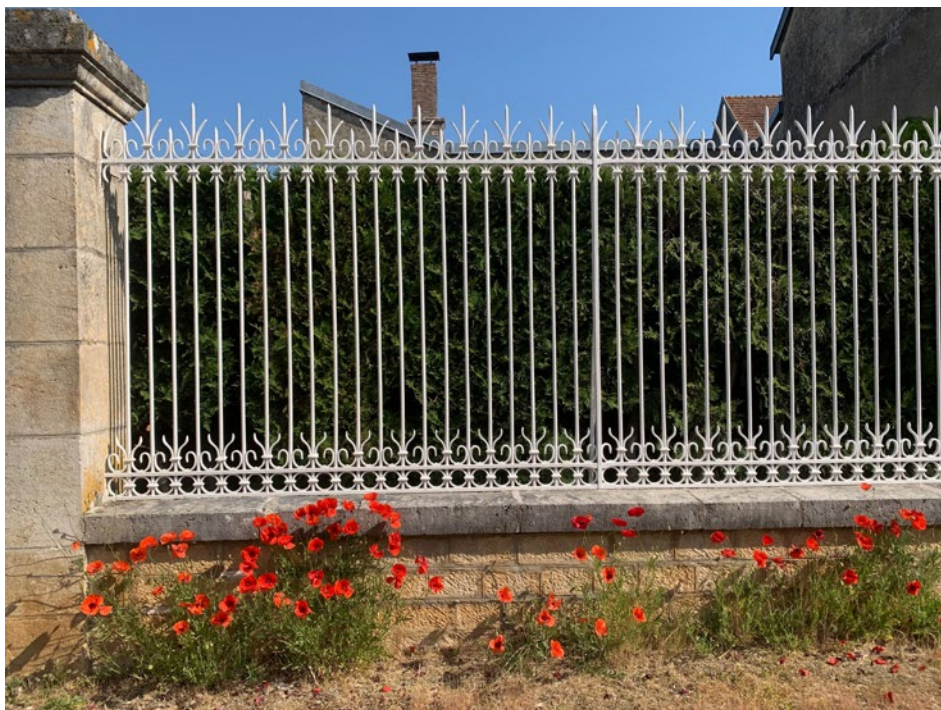
La grille surmontant un mur bahut de Dancevoir (52) © Parc national de forêts
