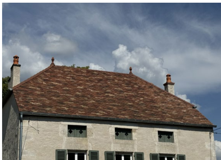
Un toit restauré en tuiles plates nuancées à Arbot (52) © Esther WOLHEIM
