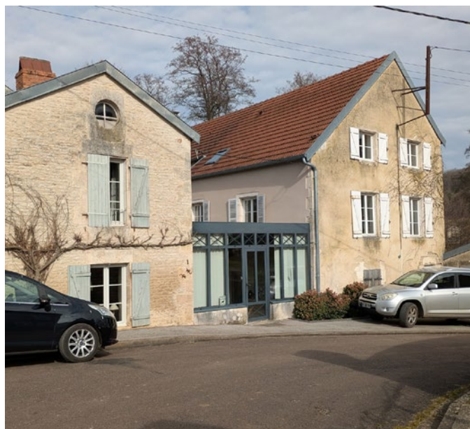
Une véranda reliant deux bâtiments anciens à Giey-sur-Aujon (52) © Parc national de forêts
