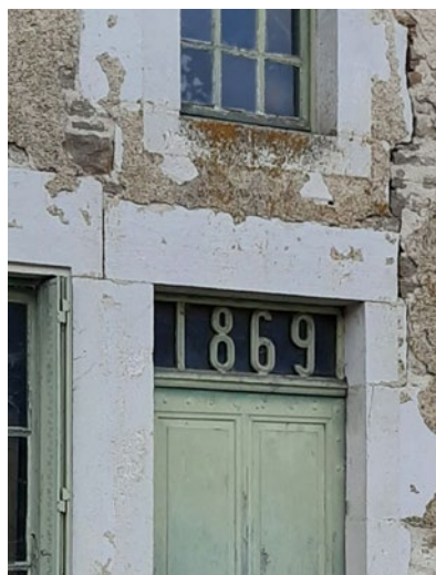
L'imposte vitrée, généralement divisée par de petits bois, accueille ici la date de construction du bâtiment. Aulnoy-sur-Aube (52) © Parc national de forêts
