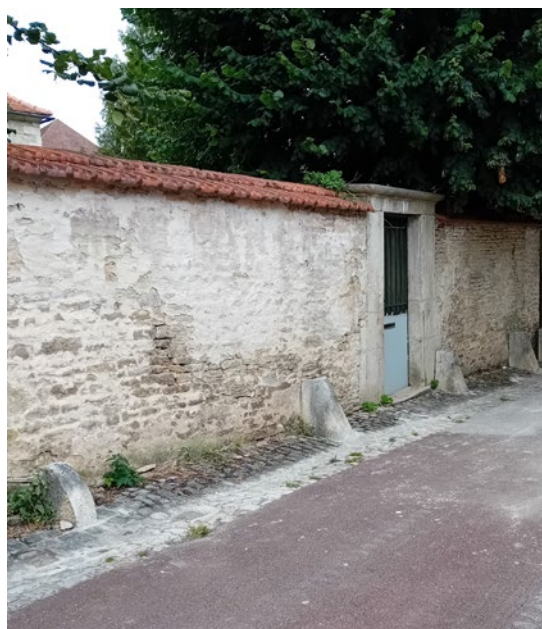
Un mur de clôture couronné de tuiles mécaniques et dotés de chasse-roue à Châtillon-sur-Seine (21) © Jean-Louis COUDROT
