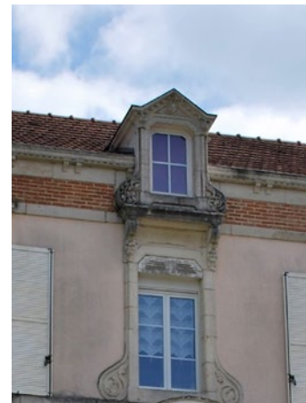
Une lucarne passante dans une demeure d'Arc-en-Barrois (52) © Daniel GUILLEMIN
