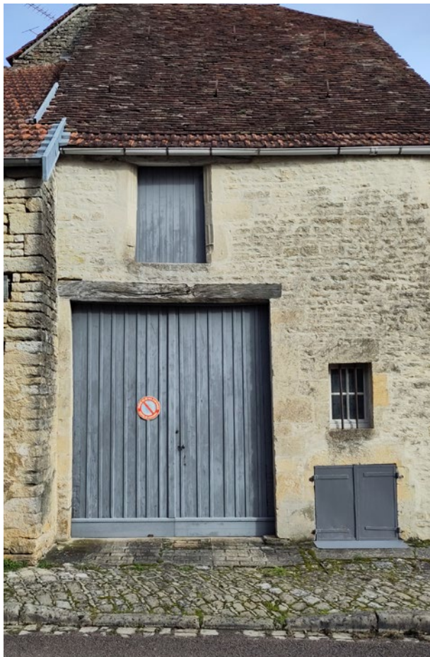
Une porte de remise à encadrement droit et linteau en bois à Châteauvillain (52) © Parc national de forêts
