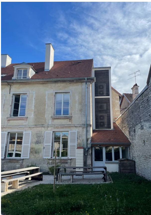
Une extension à ventelles masque des pompes à chaleur, à Arc-en-Barrois (52) © Parc national de forêts
