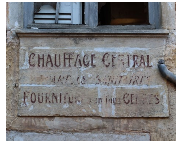
Un enduit peint servant d'enseigne. © Parc national de forêts
