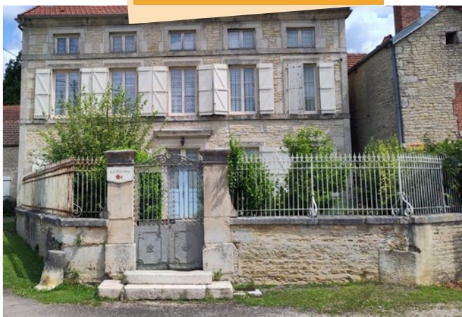
Mur de clôture en village, complété de ferronneries à Coupray (52) © Parc national de forêts
