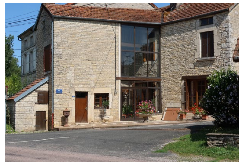
Une paroi vitrée peut permettre de créer des volumes habitables lumineux à la jonction de deux bâtiments, comme ici à Coupray (52) © Parc national de forêts
