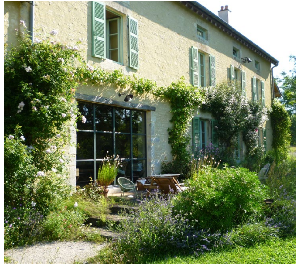
Les larges baies des dépendances agricoles peuvent accueillir des baies vitrées comme ici à Latrency-Ormoy-sur-Aube (52) Attention aux matériaux et au dessin des menuiseries © Bernard BONNEVIE
