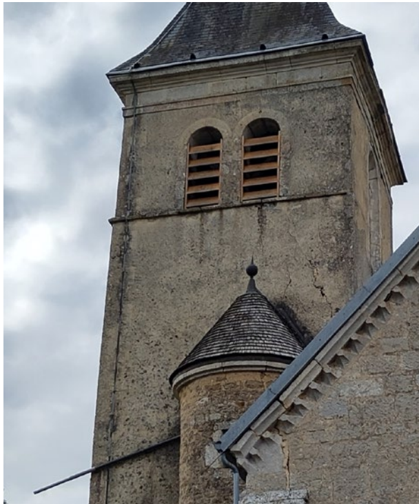
La couverture en bois d'une tourelle du clocher de Chameroy (Rochetaillée, 52) © Parc national de forêts
