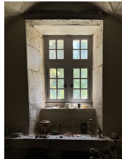
Une fenêtre à petit carreaux restituée pour occuper le fond d'une niche murale, à Rouelles (52) © Esther WOLHEIM
