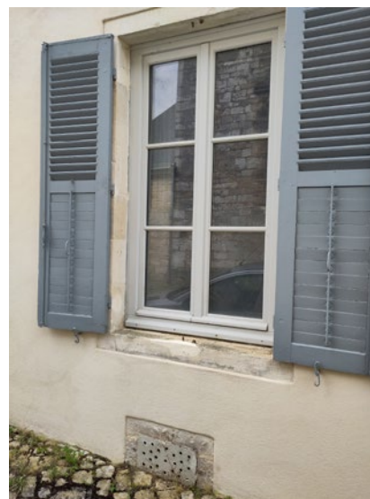
Détails de fenêtres restituées d'après des profils traditionnels, avec pièce d'appui en quart-de-rond et jet d'eau en doucine © Parc national de forêts
