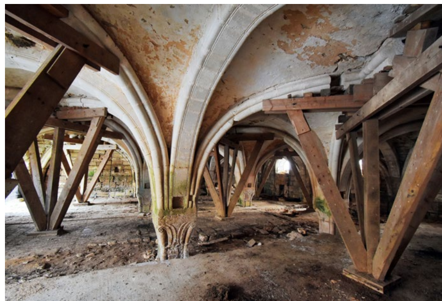
Les chapiteaux et voûtes du 12 e siècle de la Maison-Dieu de Mormant (Leffonds, 52) © Cédric CLAUDET
