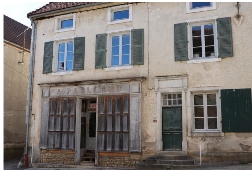
Maison à devanture ancienne, à Recy-sur-Ource (21) © Parc national de forêts
