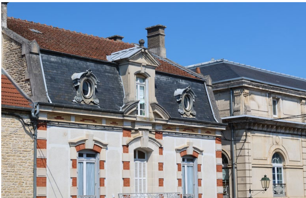
Un toit en ardoises sur une maison de bourg de Châteauvillain (52) © Parc national de forêts
