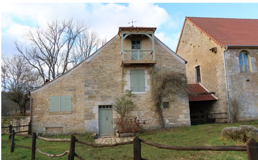
Un moulin à Dancevoir (52) aux menuiseries vert clair sur une maçonnerie de pierre © Parc national de forêts
