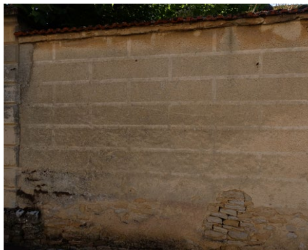
Un enduit à motif de faux appareil. © Parc national de forêts
