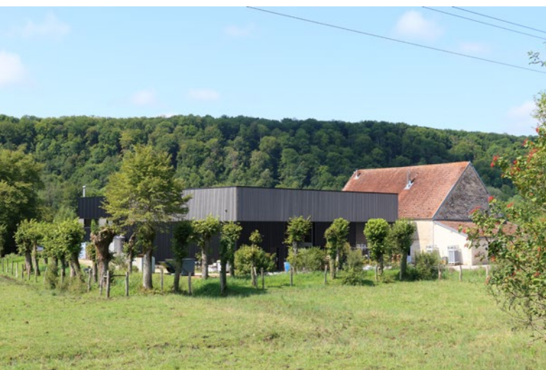
Un bâtiment artisanal à Giey-sur-Aujon (52), construit dans la continuité de bâtiments traditionnels et environné de plantations © Parc national de forêts
