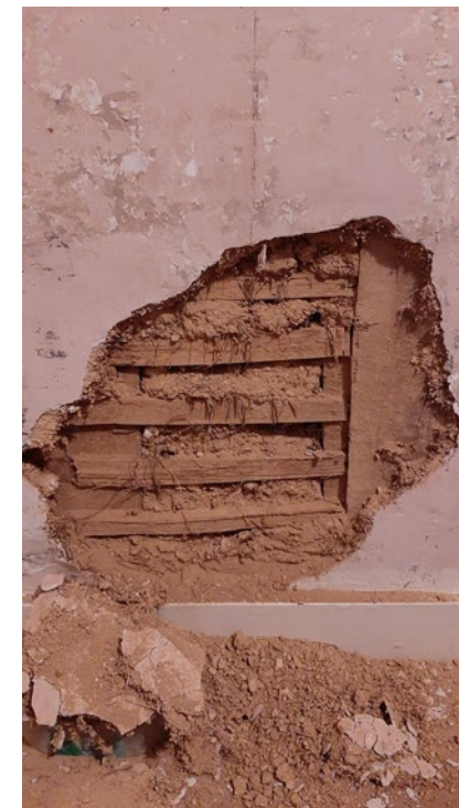
Une cloison intérieure à pans-de-bois, remplie de terre sur éclisses et revêtue d'un enduit © Parc national de forêts
