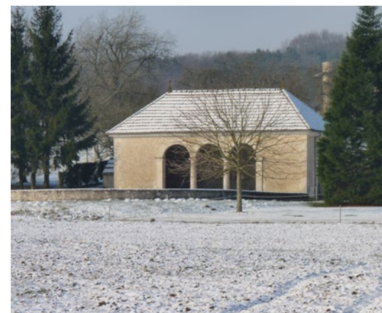
Le lavoir de Perrogney-les-Fontaines (52), précédé d'un égayoir en fer-à-cheval pavé pour le bétail © Parc national de forêts
