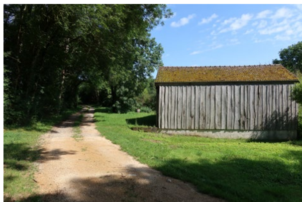
Exemple de bardage vertical avec couvre-joints, à Coupray (52) © Parc national de forêts
