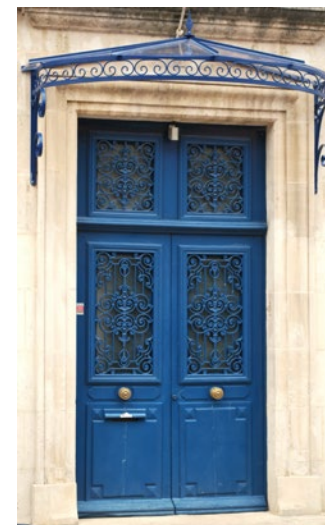
Une marquise à Arc-en-Barrois (52), en surplomb de la belle porte à grilles ouvragées d'une maison de bourg © Parc national de forêts
