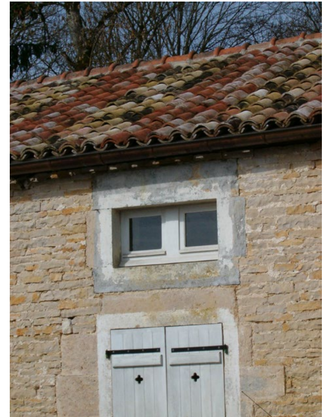
Un toit en tuiles creuses à Montigny-sur-Aube (21) © Bernard BONNEVIE
