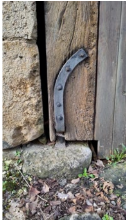
Détail d'un gond métallique de porte de grange © Parc national de forêts
