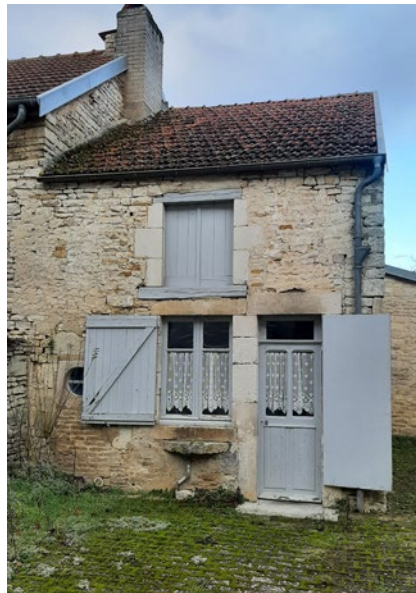
Maison rurale à Aubepierre-sur-Aube (52) © Parc national de forêts
