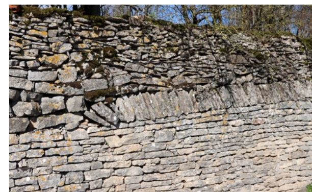
Un mur de clôture en pierre sèche, initialement couvert de dalles dressées puis rehaussé, à Recey-sur-Ource (21) © Parc national de forêts
