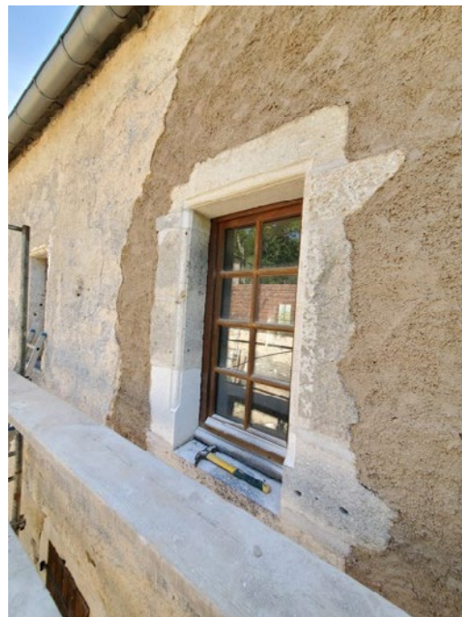
Restauration (en cours) d'un enduit ancien ©OlivierVECOVEN
