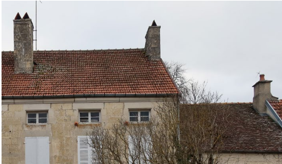
Des souches de cheminée en moellons enduits, couvertes de mitres en terre cuite, à Rochetaillée (52) © Parc national de forêts
