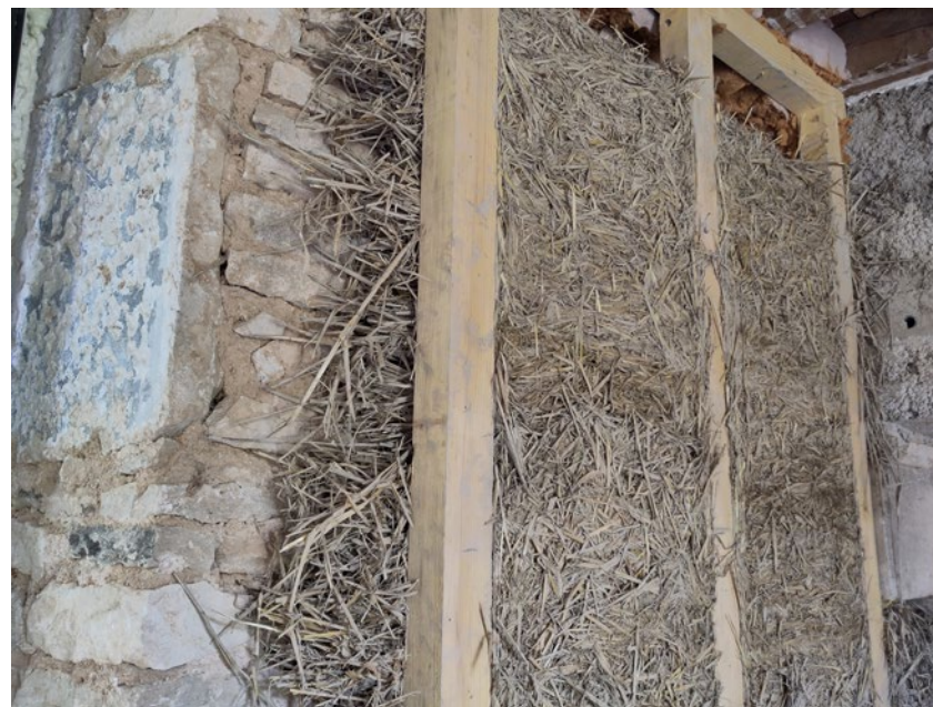
Mise en place d'une isolation à base de paille dans un cadre de bois © Parc national de forêts
