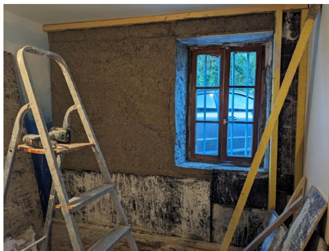
Isolation d'un mur avec un « béton » de chanvre et de chaux © Villages anciens, Villages d'avenir
