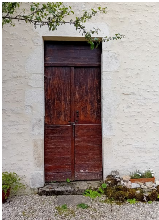
Détail d'un mur enduit à pierres vues © Jean-Louis COUDROT
