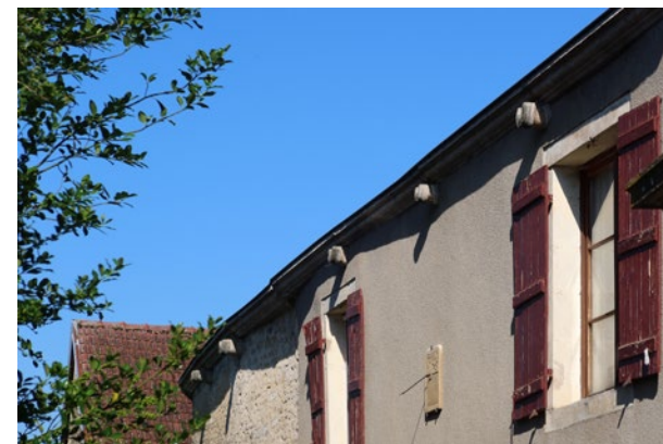
D'anciens exutoires d'eau pluviale sur une demeure de Châteauvillain (52) © Parc national de forêts
