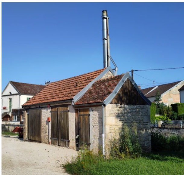
D'anciennes remises converties en chaudière collective à plaquettes forestières à Leuglay (21) © Parc national de forêts
