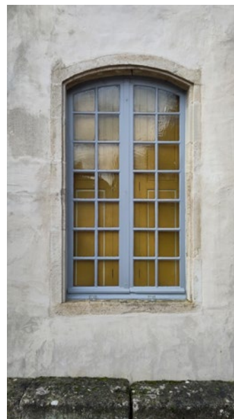
Un encadrement couvert d'un arc segmentaire (ou surbaissé) dans une demeure de Châteauvillain (52) © Parc national de forêts
