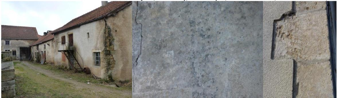
Figure 51 : Altérations des revêtements de façade et rénovation inappropriée, Vesvres-sous-Chalancey, Leuglay, ©GIP-PNFCB-LM, 2011-2012.
