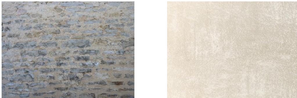
Figure 39 : Enduit à pierre vue, enduit couvrant, Leuglay, ©GIP-PNFCB-LM, 2011-2012.
