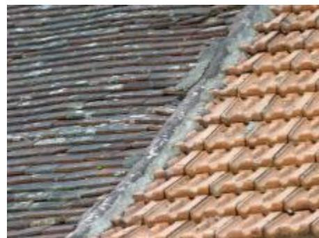
Figure 42 : Toiture en lave à Cussey-les-forges, tuiles plates et tuiles mécaniques à Praslay, ©GIP-PNFCB-LM, 2011-2012.
