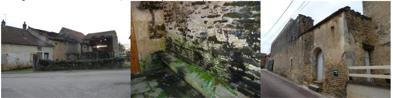
Figure 50: Altérations de structure et des revêtements de façade, Chalancey, Montmoyen, Brion-sur-Ource, ©GIP-PNFCB-LM, 2011-2012.
